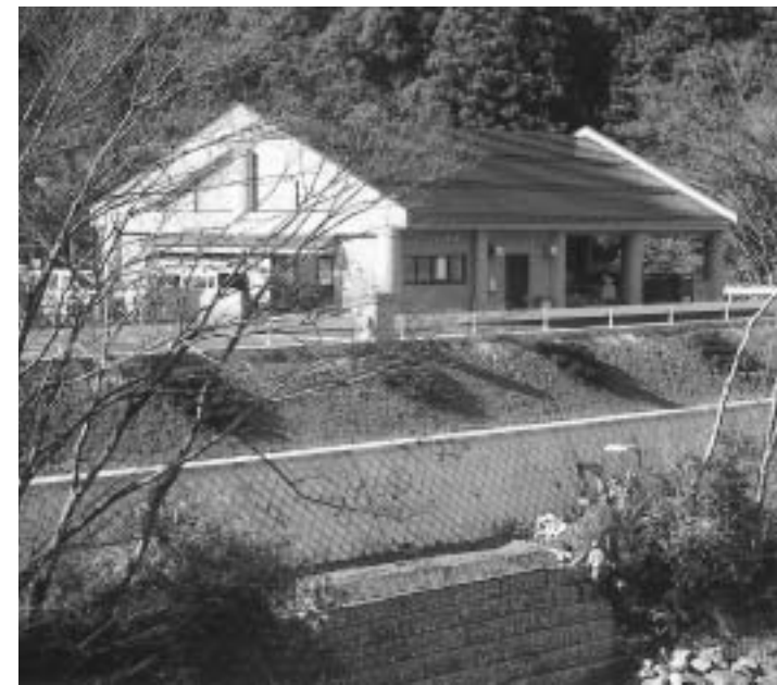
完成まじかの佐目地区下水道処理施設
